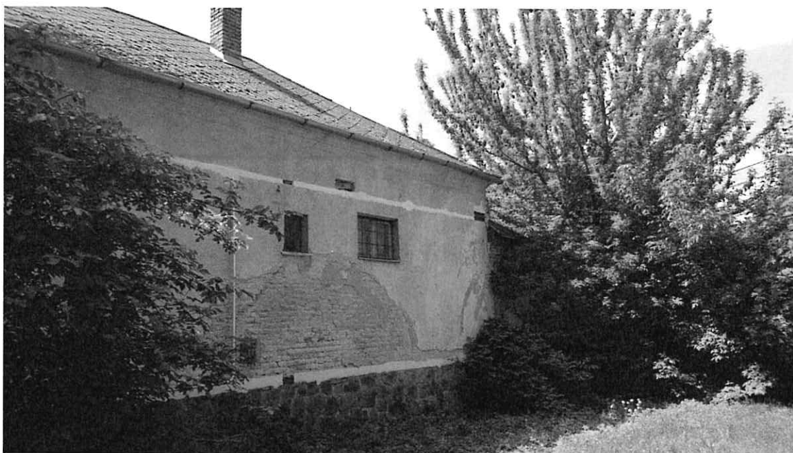
Az ÉNy-i homlokzat, a fa takarásában helyezkedik el a bontandó szárny. A fa és a bokrok visszavágása a tető visszaépítése miatt is szükséges.
