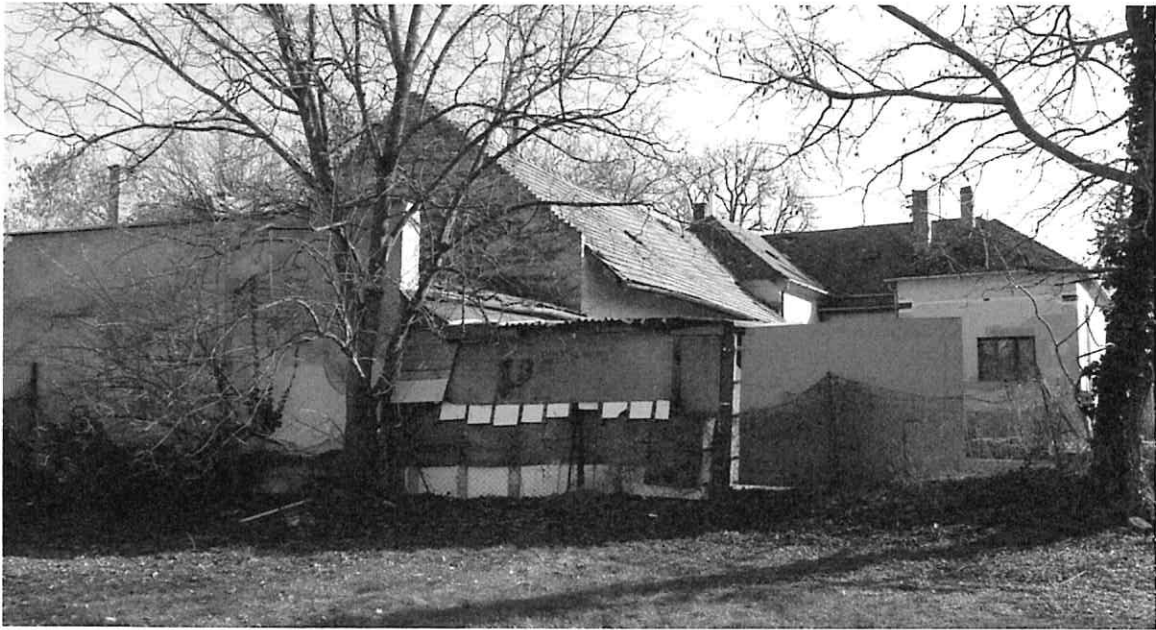
Bontandó a hátsó szárny és a kerítéshez épített melléképítmények: a könnyűszerkezetes gépkocsi tároló és a fedett tároló.
