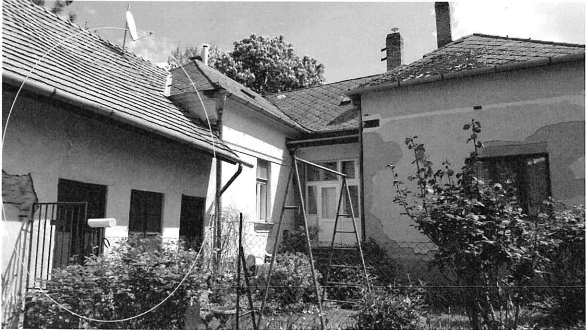
Az épület belső szárnyának megtartandó részén a tető kerül bontásra. Megmarad a pincelejáró, műhely és padlásfeljáró.
